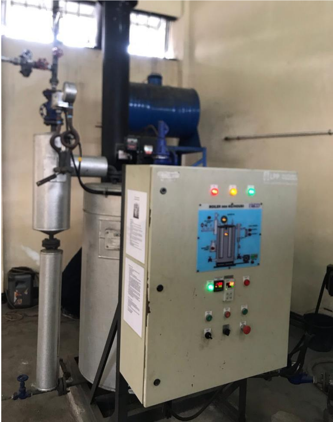
Gambar 3.53. Boiler jenis TWA 300kg/hours
