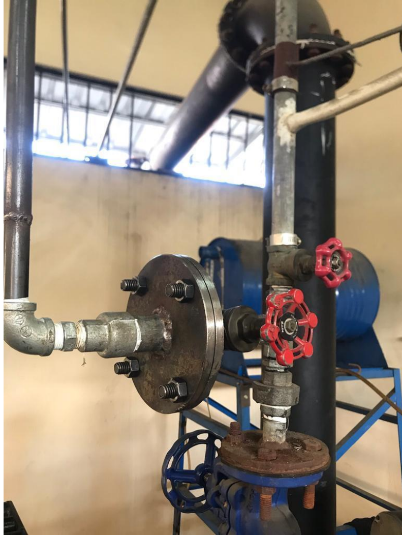
Gambar 3.54. Pemasangan gasket pada flens di saluran boiler
