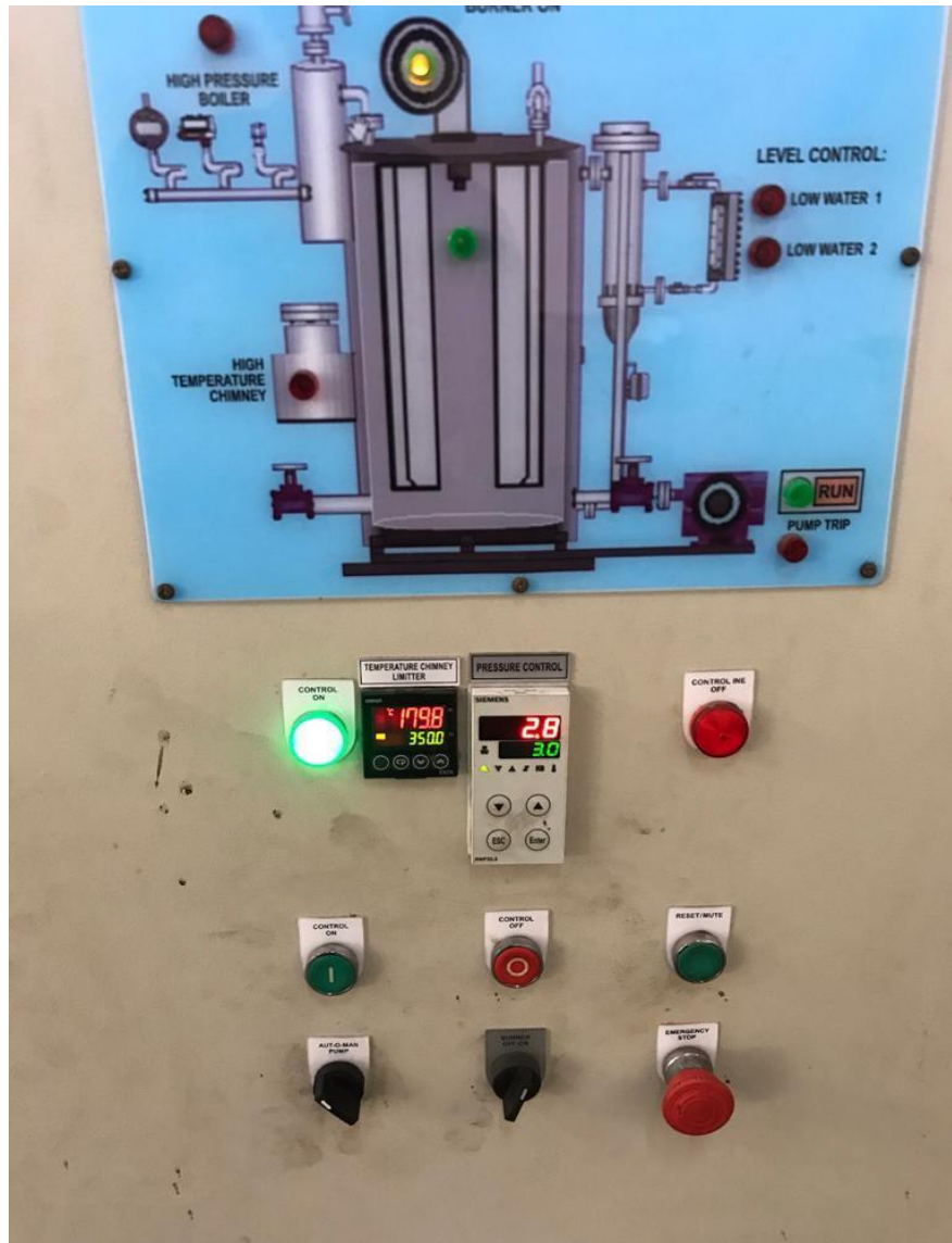
Gambar 3.57. Penunjukan tekanan pada panel
